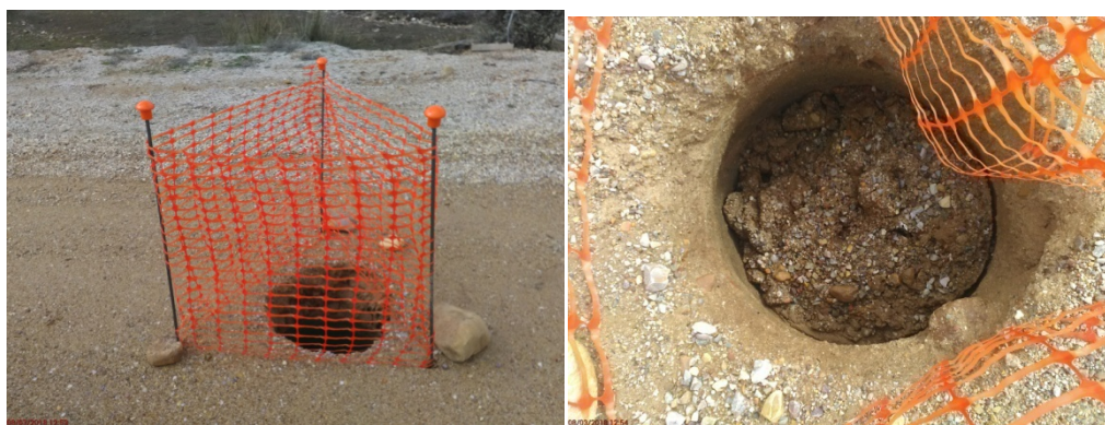
Pozo hundido por lavado del material de relleno.
