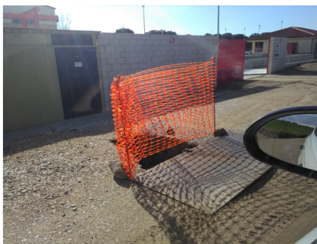
Pozo hundido frente a centro de transformación.
